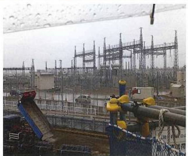
【白山車両基地現場】
