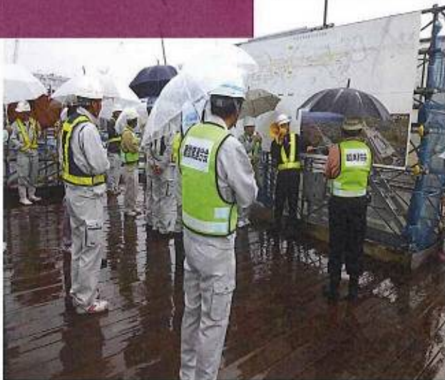
【白山車両基地現場】
