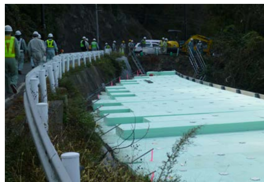
【通常砂防工事 羽賀その1】
